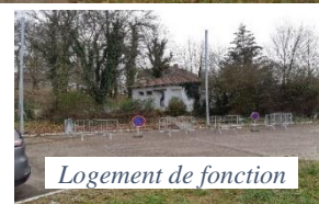
Février 2023 après déconstruction
